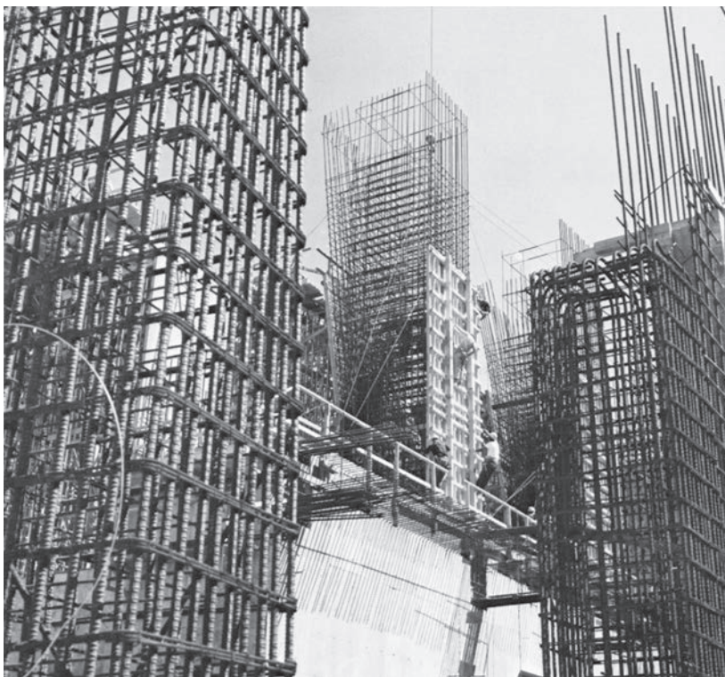
Enormes columnas de concreto con refuerzo. (Cortesía de Bethlehem Steel Corporation.)
