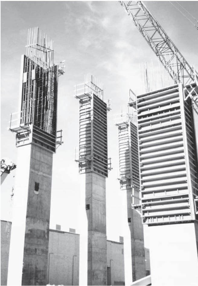
Centro de Convenciones de Richmond, Richmond, Virginia. Observe los cambios del tamaño de columna. (Cortesía de EFCO.)
