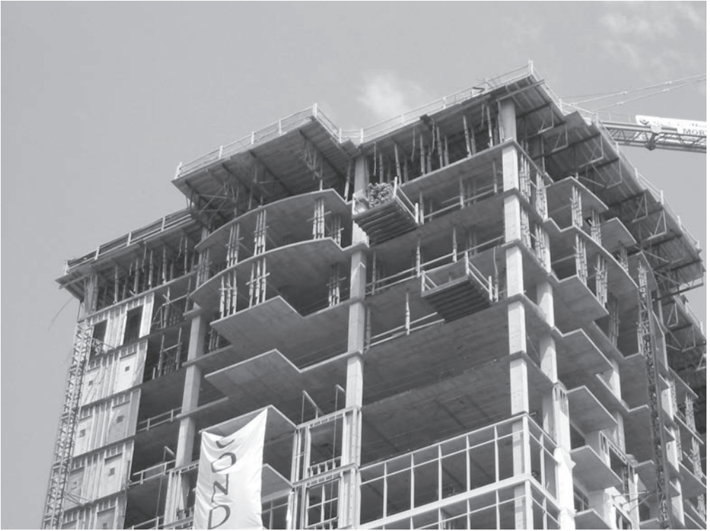
Construcción con placa plana: Condominios Pharr Road, Atlanta, GA. (Cortesía del Prof. Larry Kahn, Georgia Institute of Technology.)
