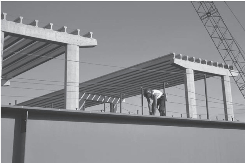
Construcción de un puente. (PhotoDisc, Inc./Getty Images.)
