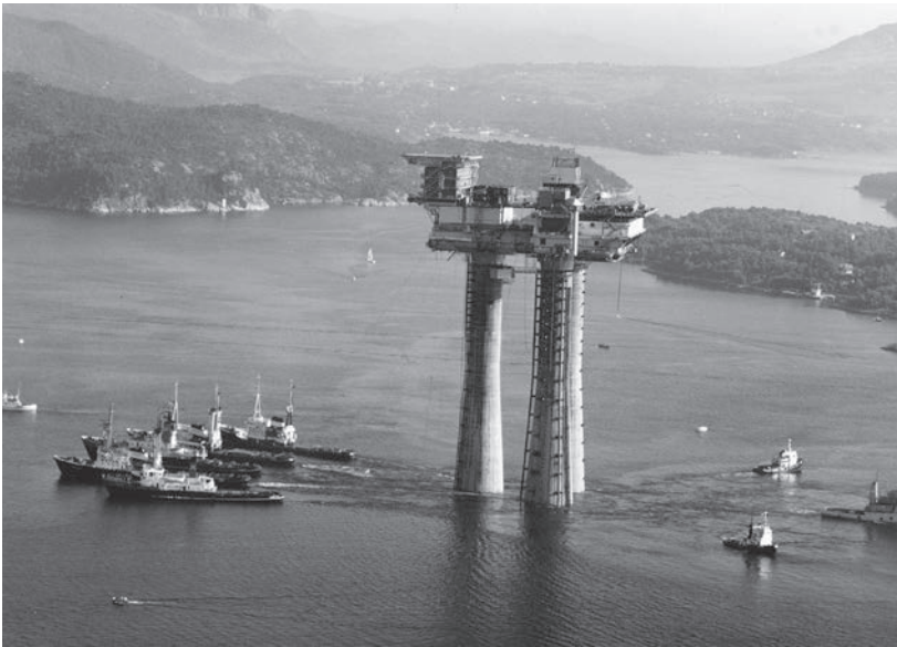
Remolque de dos cilindros huecos de concreto reforzado, cada uno de 65 pies de diámetro y 185 pies de altura, en el Mar del Norte, como parte de una plataforma perforadora de petróleo. (Cortesía de United Nations, J. Moss.)
