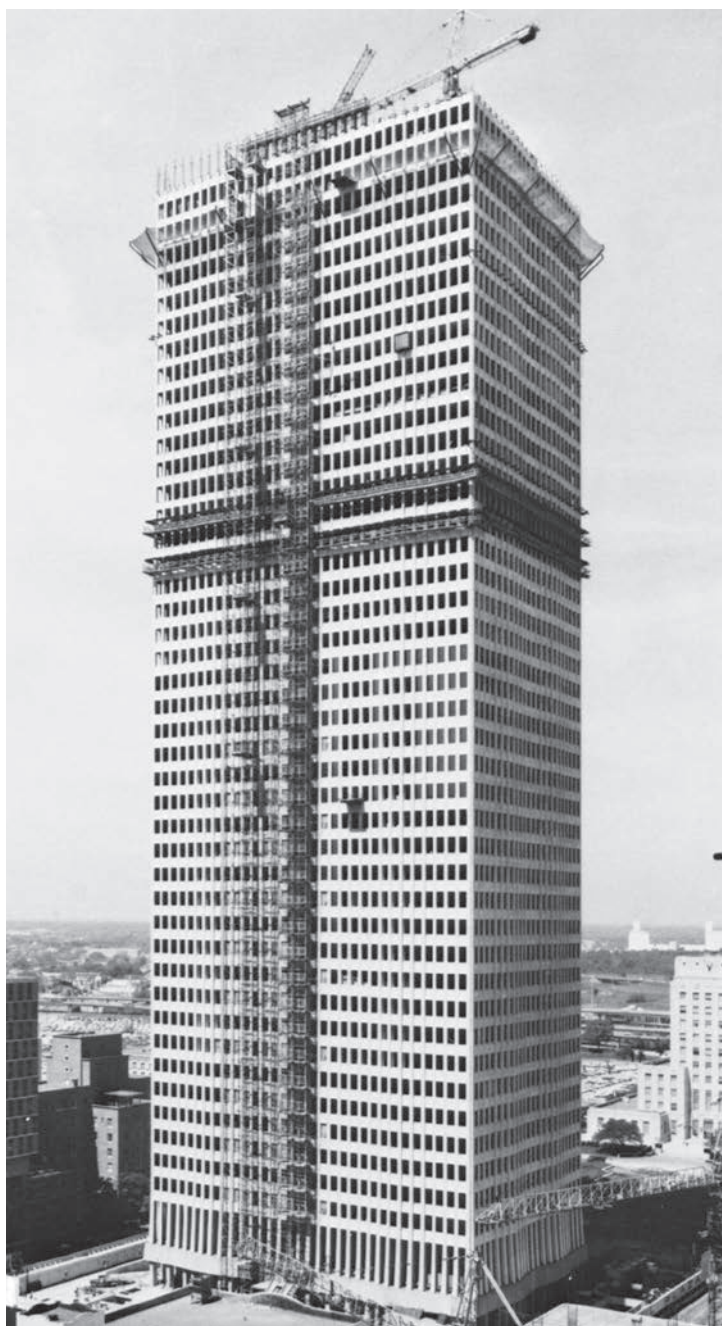
Plaza One Shell, Houston, Texas, que tiene 52 niveles y una altura de 714 pies. (Cortesía de Master Builders.)
