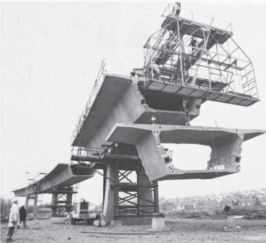
Segmentos postensados y precolados de concreto para el viaducto East Moors, en Lanbury Way, Cardiff, Gales del Sur. (Cortesía de Cement and Concrete Association.)
