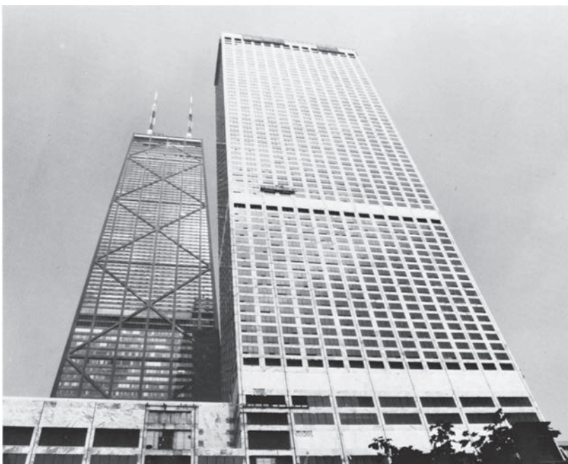
Water Tower Place, Chicago, Illinois, el edificio más alto de concreto reforzado en Estados Unidos (74 niveles, 859 pies). (Cortesía de Symons Corporation.)
