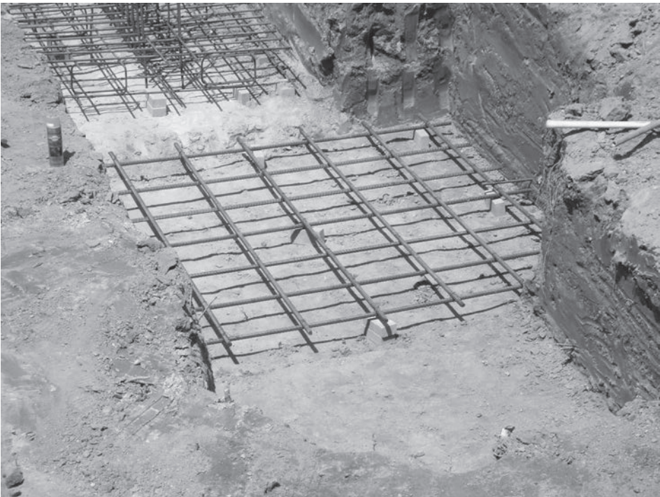
Zapata aislada para una columna antes de la colocación del refuerzo de la columna, Anexo de Rodas: Clemson University, 2008.
