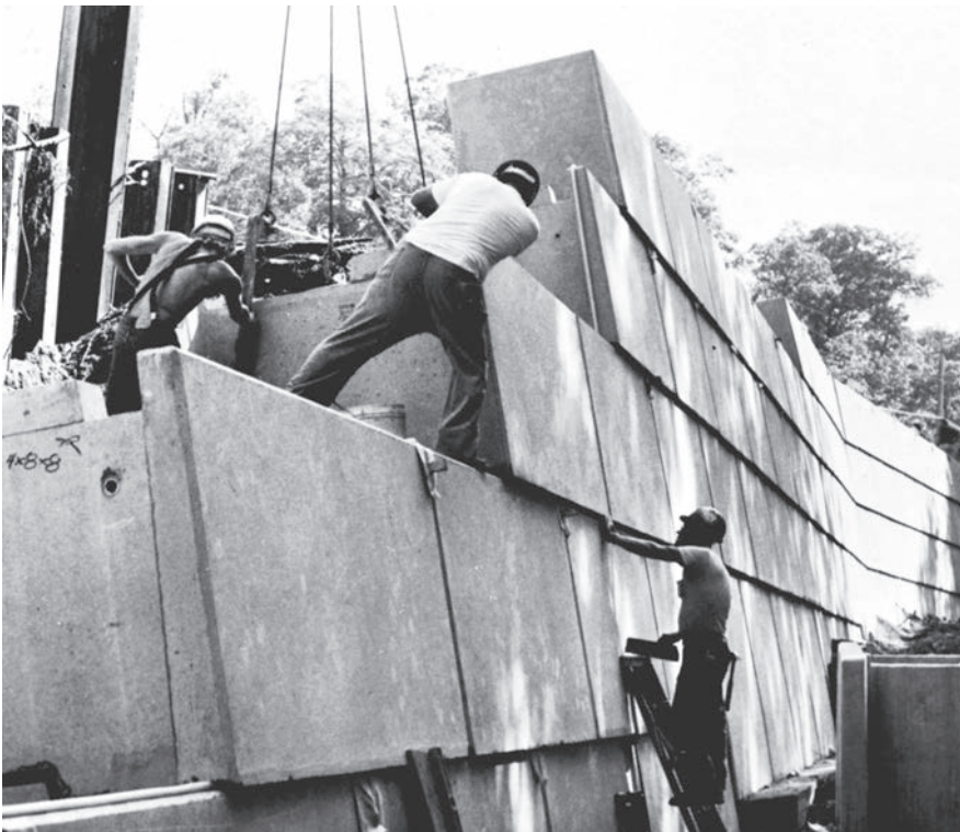
Muro de retención para el ferrocarril Long Island, Huntington, Nueva York. Construido con módulos interconectados de concreto reforzado precolados. (Cortesía de Doublewal Corporation.)
