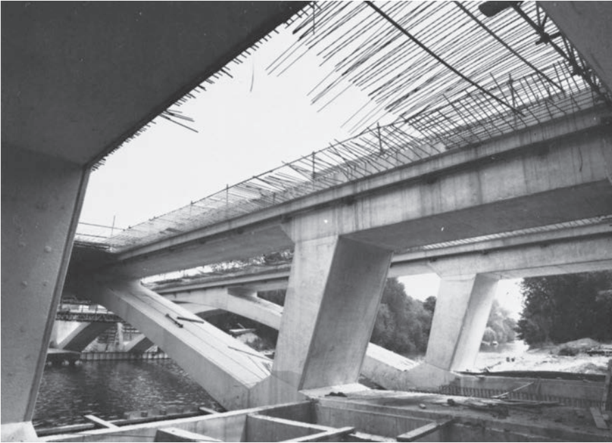
Puente Runnymede de concreto presforzado sobre el Río Támesis, cerca de Egham, Surrey, Inglaterra. (Cortesía de Cement and Concrete Association.)
