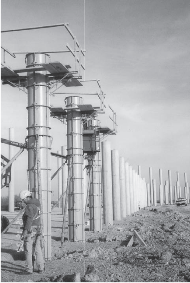
Cimbras redondas para columnas de graderías en The Texas Motor Speedway, Fort Worth, Texas. (Cortesía de EFCO Corp.)
